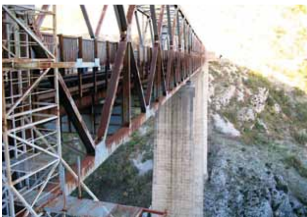
Most Mala Rijeka, eden največjih jeklenih železniških mostov v Evropi.
